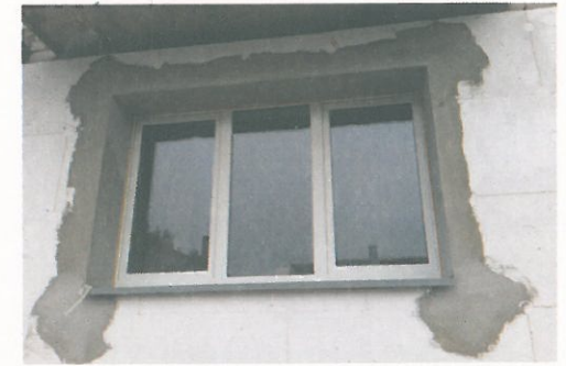
Tinkamai suklijuotos šiltinimo plokštės
